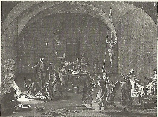
Follerraum der Inquisition von Picart (1673-1733)
